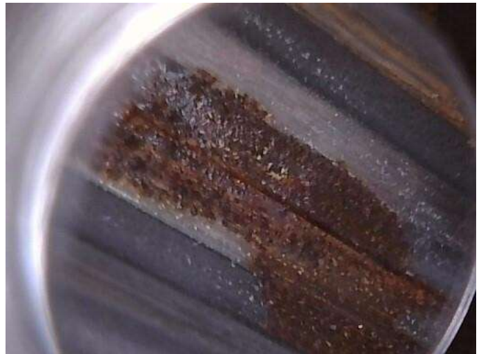
Foto N° 1. Oxido al interior del cañón
